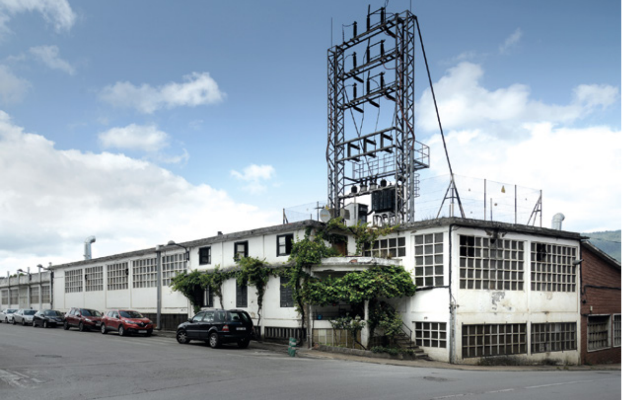
📷 Fabriken garai gorenen arrastoak ugariak dira (Goian). Beste lantegi batzuk eraldatu eta garai berrietara egokitu dira (behean).
