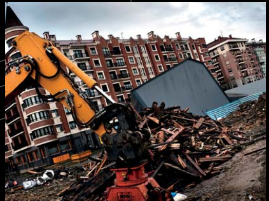
📷 Derribo de la estación de tren de Durango.
