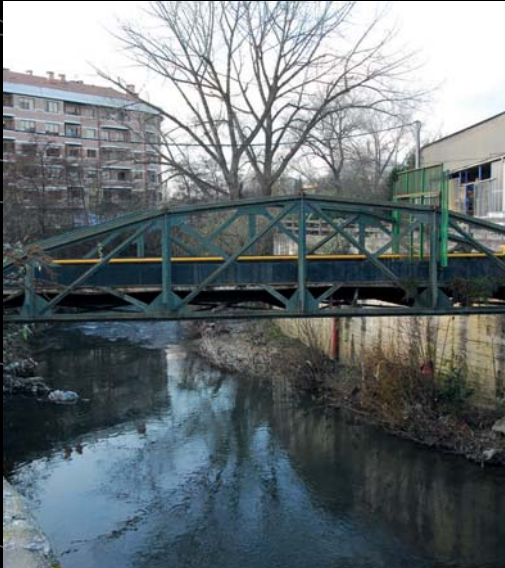
📷 Puente junto a la Ferretera.
