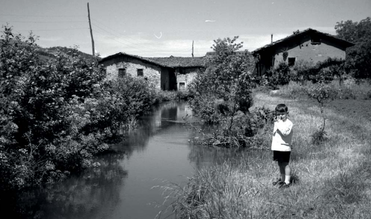
📷 Antepara y edificio de la ferrería. Ricardo Doliwa, 1950.
