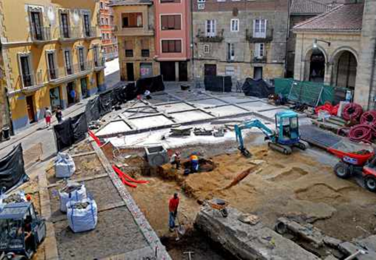
La práctica de la urbana exige compaginar los ritmos de las obras de la ciudad con los de la investigación arqueológica. Obras y excavación en la plaza de Santa Ana
